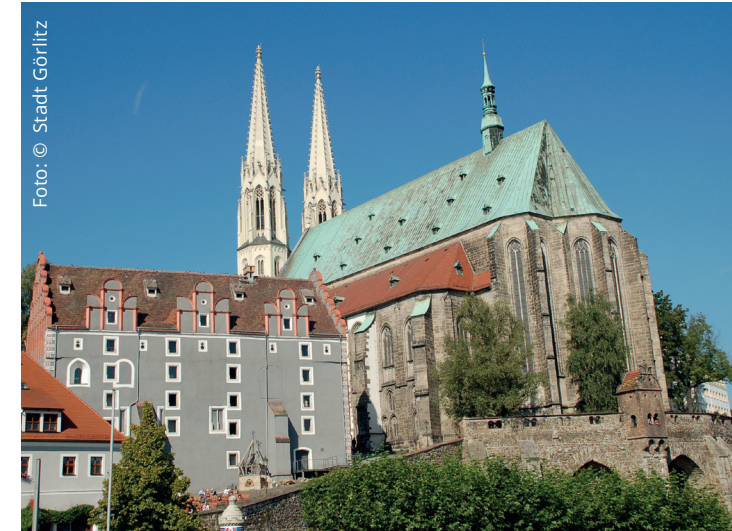
Restaurierungswerkstätten im Waidhaus Görlitz - Ausbildungsstandort im Praxisteil
